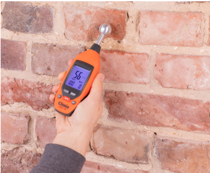
Misura non distruttiva con sensore a contatto
