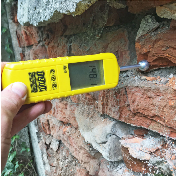
Rilevo dell'umidità su muratura esistente
