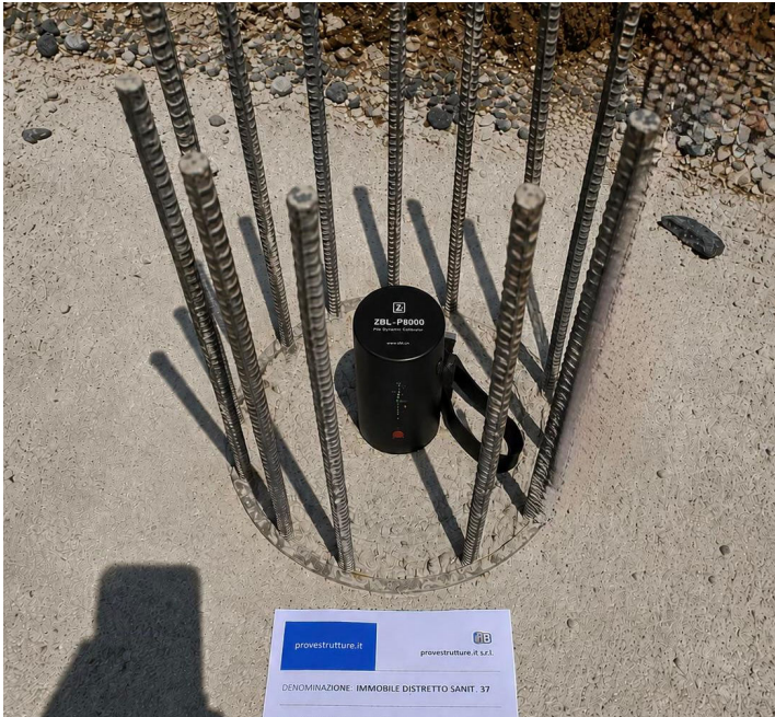
Esecuzione della prova su palo di fondazione
