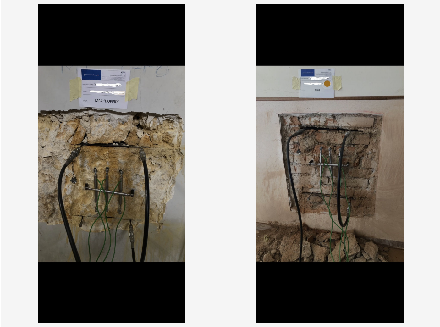
Allestimenti di prova - fotografie originali fornite
