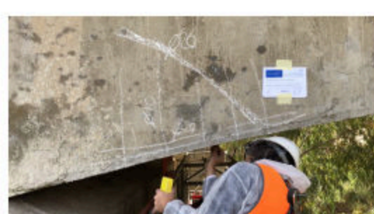
1 Rilievo e tracciamento
